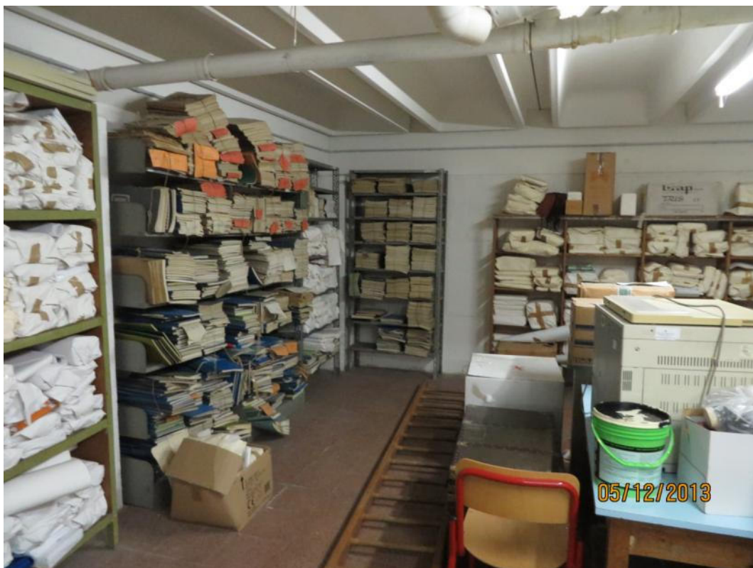
Locale archivio in cui creare l'adeguata ventilazione
