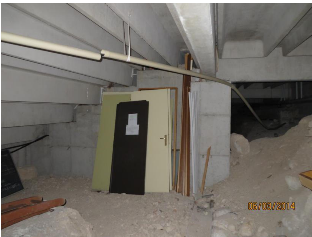
Sottotribuna: zona da ristrutturare per realizzare l'ampliamento del deposito
