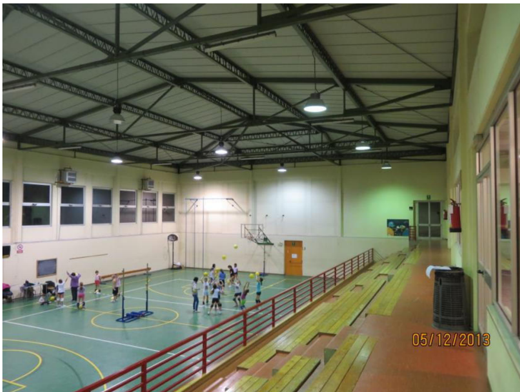
Interno palestra visto dalle tribune, sul fondo la muratura su cui ricavare le porte di deflusso
