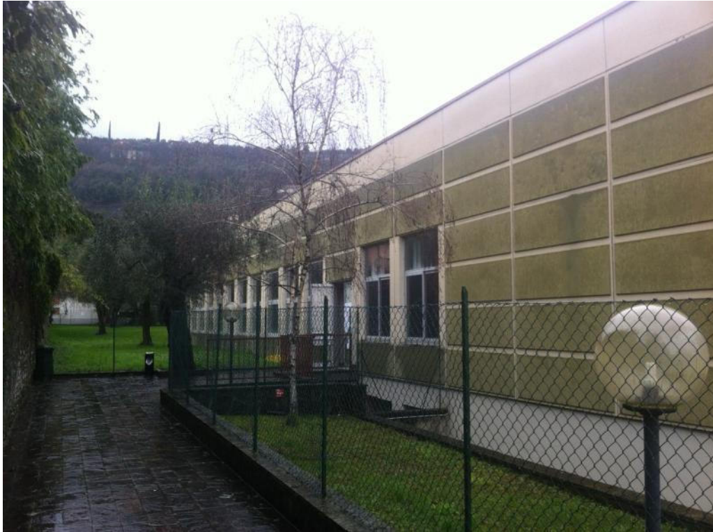
L'accesso esterno alla sala polivalente
