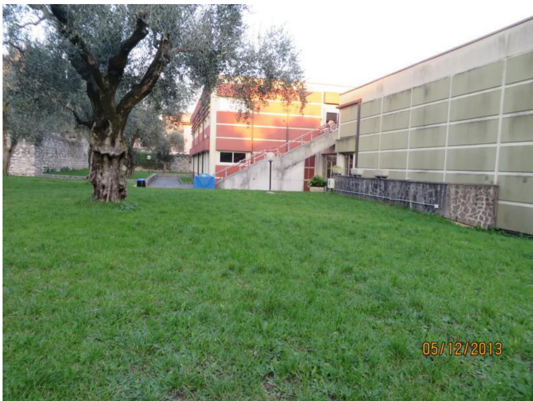
Lato ovest, con l'attuale scala di uscita dalla palestra interrata
