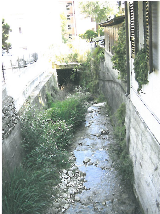
Vista del Torrente Bornico e sottopasso di Via Bornico.
