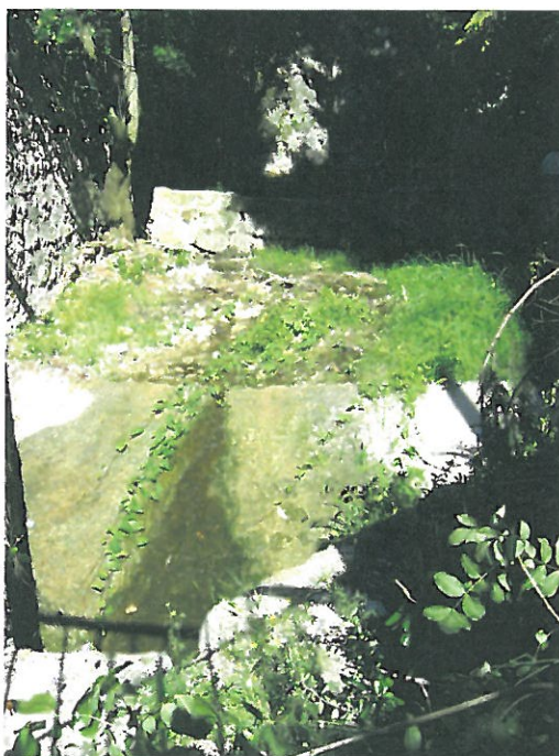
Vista del sottopasso in cunicolo di Via Montemaderno a quota 98.0 m. s.l.m. ed imbocco del tratto interrato con in primo piano un piccolo salto di fondo.
