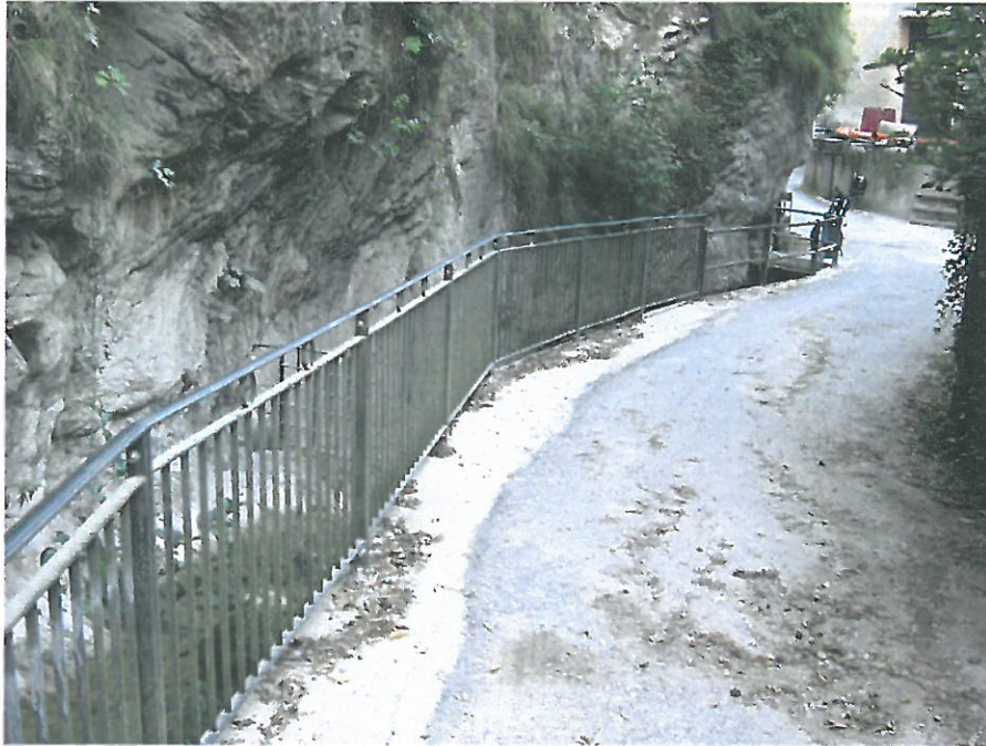
Vista del Torrente Bornico a lato di Via Olificio con, sullo sfondo, il sottopasso della strada comunale
