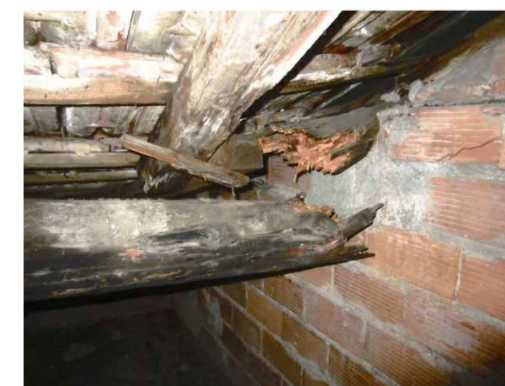
INTERNI - Foto 6 - Particolare terza sottotetto
