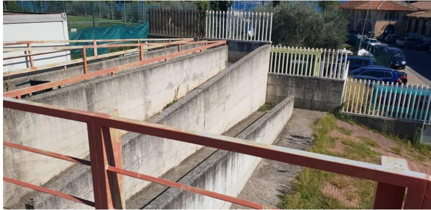
Figura 13: rampa ingresso secondario
