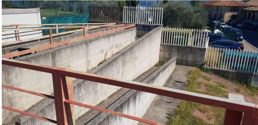
Figura 13: rampa ingresso secondario
