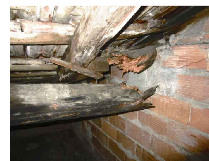
INTERNI - Foto 6 - Particolare terza sottotetto
