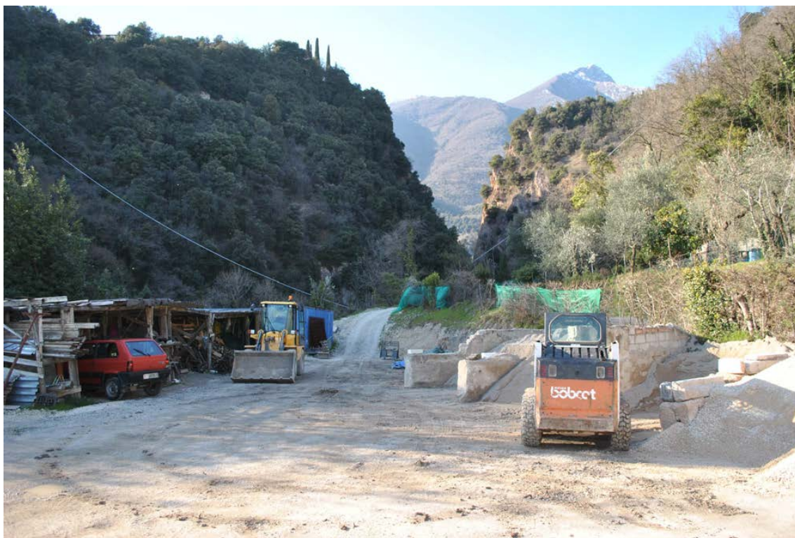
Scatto fotografico dell'area di intervento. Situazione attuale.
