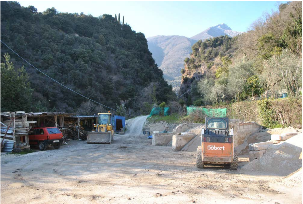
Scatto fotografico dell'area di intervento in direzione Nord-Ovest.
