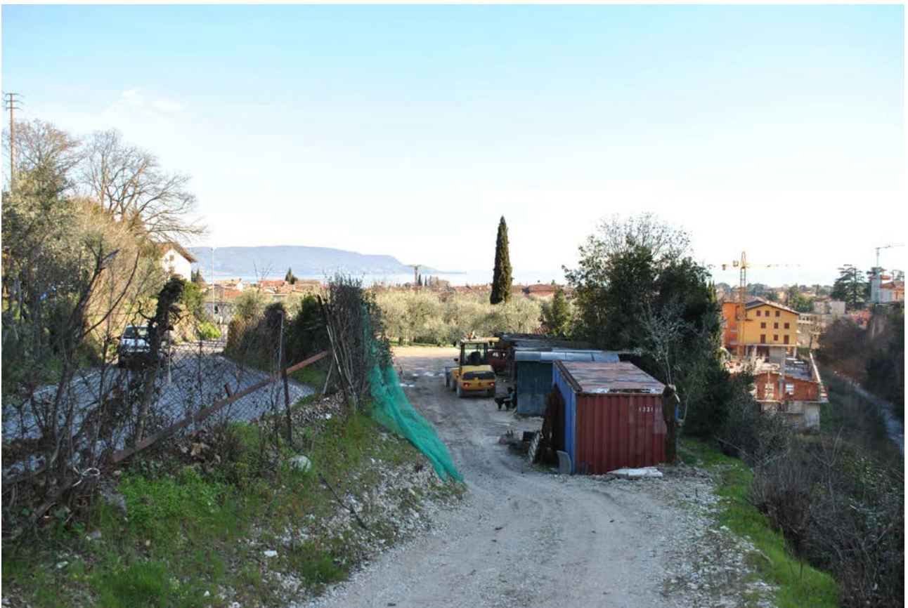
Scatto fotografico dell'area di intervento in direzione Sud-Est.
