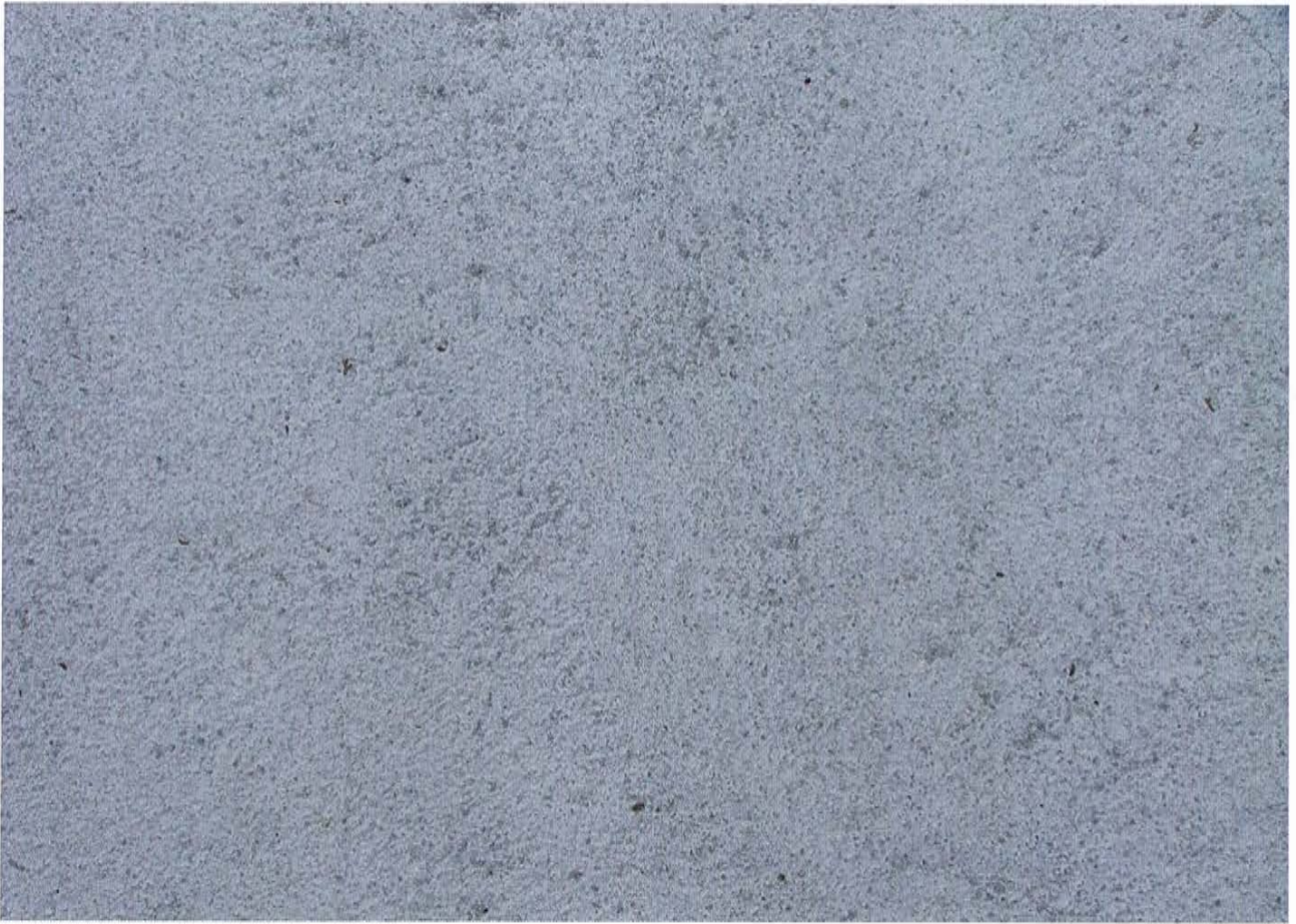
Pavimentazione in battuto di cemento
