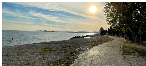
La passeggiata zona campeggi dopo i lavori
